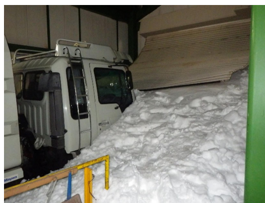
【H26 雪崩】 檜枝岐村クリーンセンター
