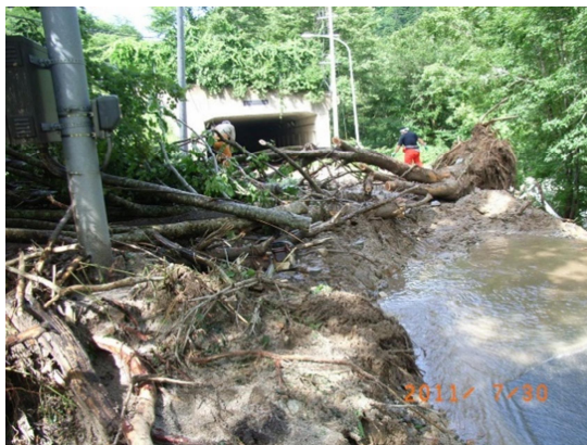
大戸沢スノーシェッド付近
